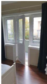
Utgang til balkong fra ett soverom.
