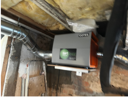
Ventilasjonssystem til krypkjeller
