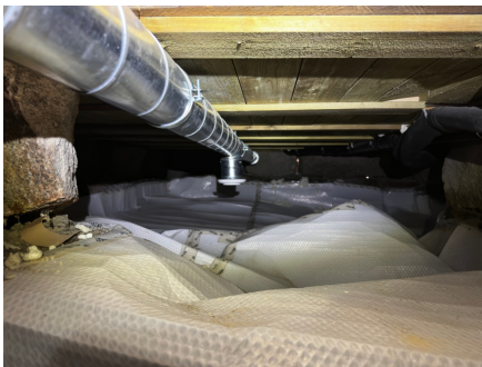
Ventilasjonssystem til krypkjeller
