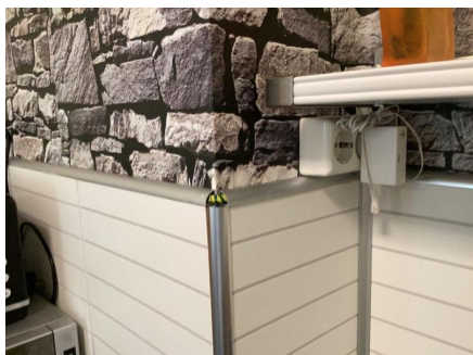
Ufagmessig utførelse av kabel.
