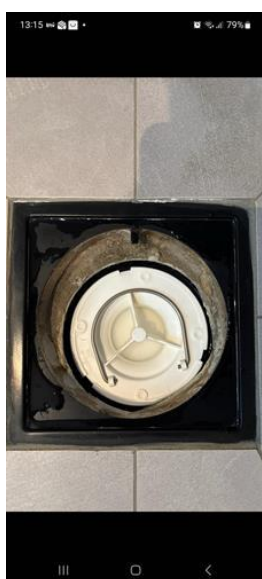
Membran, tettesjikt og overgang til sluk. - [Sluk bad.]
