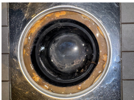
Plastsluk med klemring og synlig membran/mansjett
