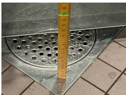
Fallforhold ca. 149 mm topp slukrist i dusjsone
