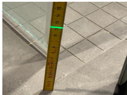
Fallforhold ca. 122 mm overkant gulv ved dusjsone
