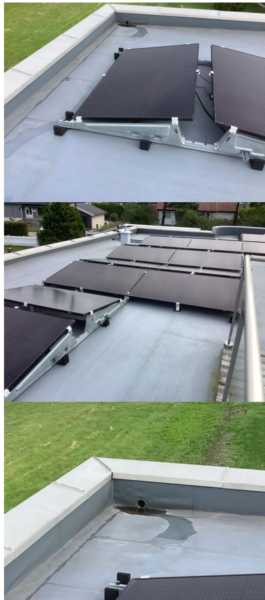
Avrenningsrør fra taket.
