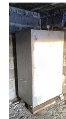
Oljetank plassert i garasjen.
