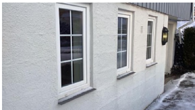
Pvc-vinduer i underetasjen.
