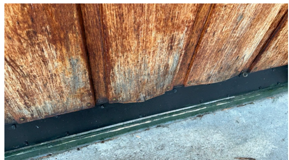
Råteskadet hoveddør
