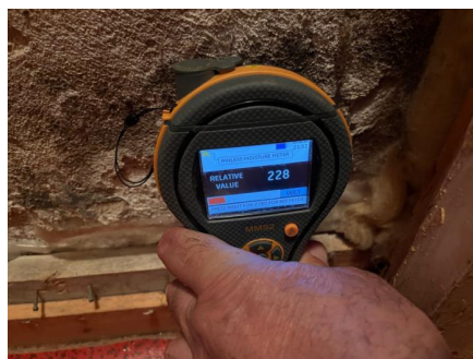
Fuktsøk på vegg i bod ved baren.
