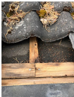
Fukt på undertak på grunn av dårlig avrenning fra taket.
