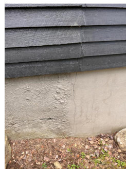
Det er ikke synlig vorteplast på nordøst side av kjeller
