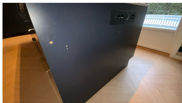
Skruehull i enden av kjøkkenøya
