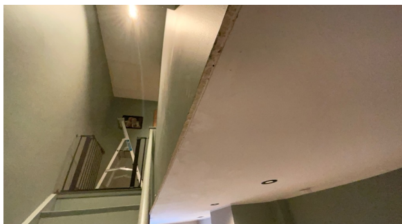
Gjenstående belistningsarbeider rundt trappeåpning.
