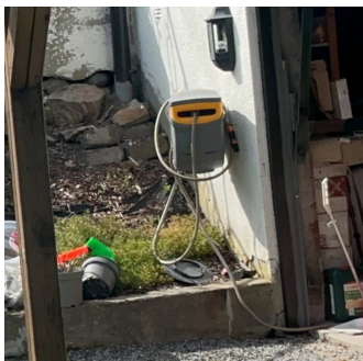
Sprekker og avflassing i grunnmur
