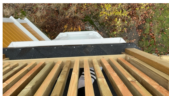
Synlige pappspiker gjennom beslag og tekking.
