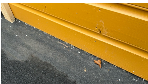
Mangler beslag og lufting.
