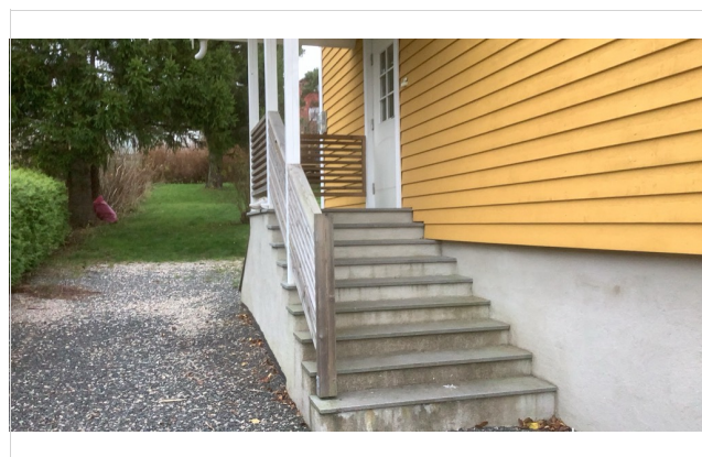
Felles utvendig trapp til inngangsdør.
