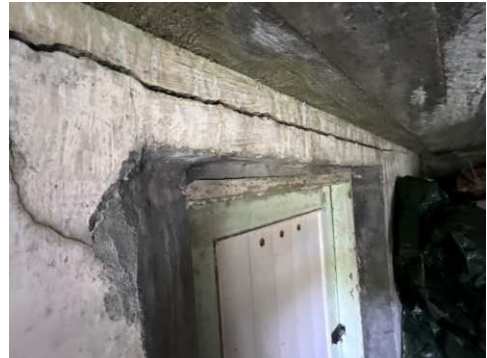
Dype sprekker i grunnmur ved overbygget kjellerinngang
