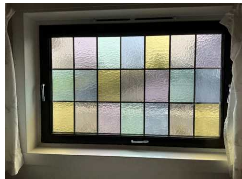
Blyinnfattet vindu på bad.
