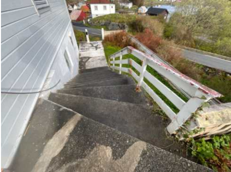
Store, åpne felt (ca. 25 cm mellom rekkverk og trappetrinn).
