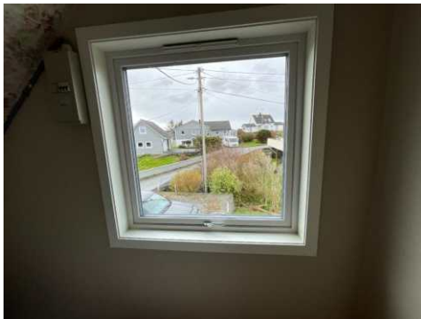
Sørveggen: Nytt vindu.
