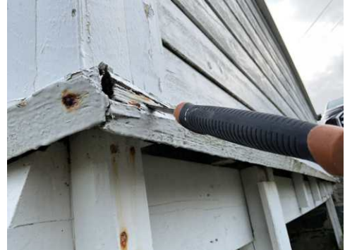
Råteskader, underside altan
