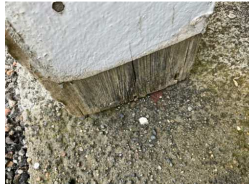
Råteskader, underside altan
