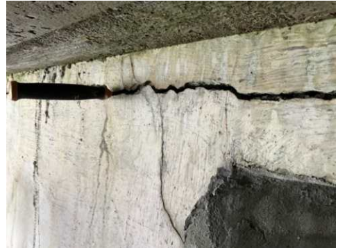
Dype sprekker i grunnmur ved overbygget kjellerinngang
