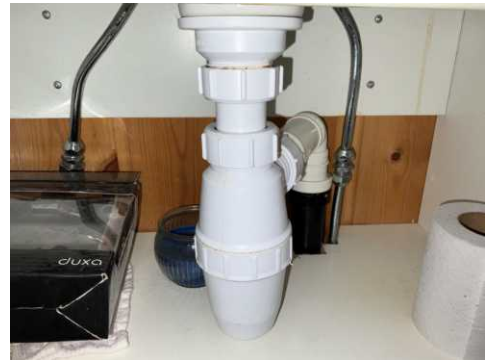
Røropplegg under håndvask, toalettområde på bad.
