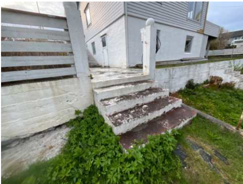
Store, åpne felt (ca. 25 cm mellom rekkverk og trappetrinn).
