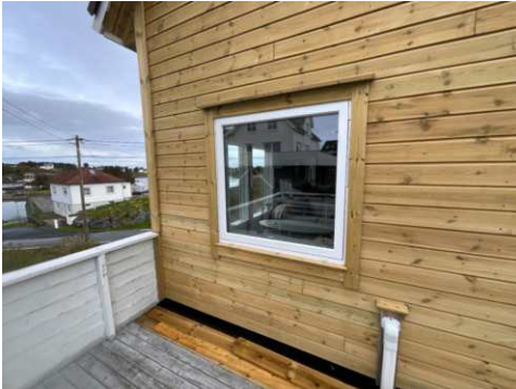
Sørveggen: Nytt vindu.
