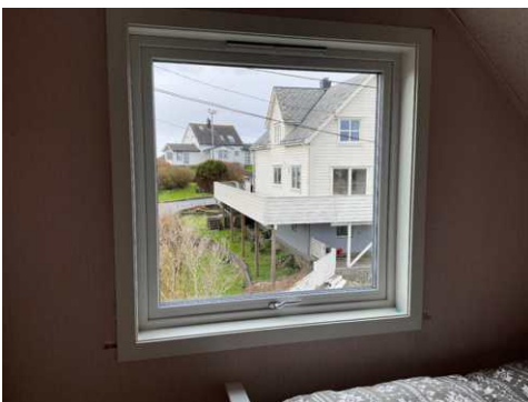
Sørveggen: Nytt vindu.
