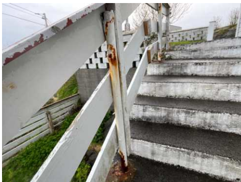
Rustet metallrekkverk.
