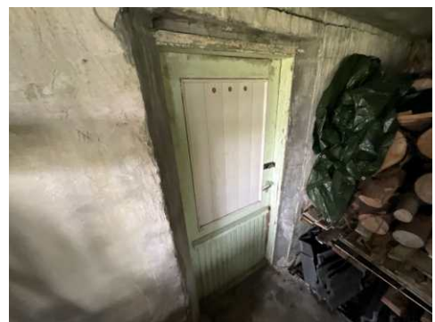
Kjellerdør tar i karm. Løst håndtak.
