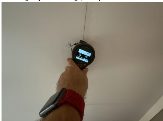
Fuktskjolder langs skjøter i himlingsplater på soverom.
