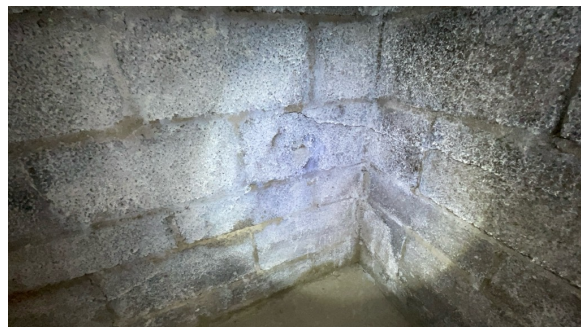
Grunnmur under garasjen
