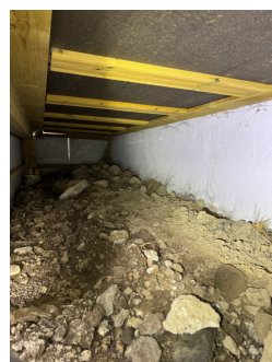
Krypkjeller/kryprom under deler av kjøkkenet.
