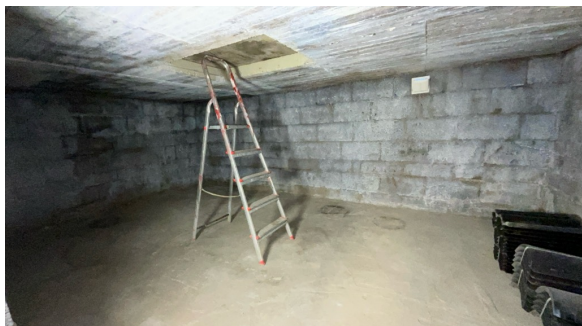
Krypkjeller/kryprom under garasjen med støpt dekke.
