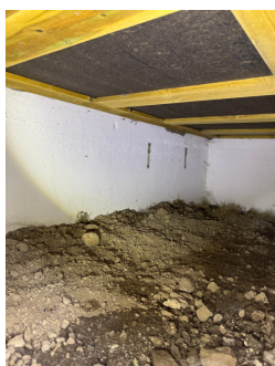
Krypkjeller/kryprom under deler av kjøkkenet.
