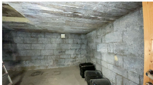
Krypkjeller/kryprom under garasjen med støpt dekke.
