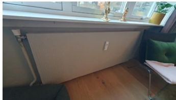
Radiator er montert i stuen.
