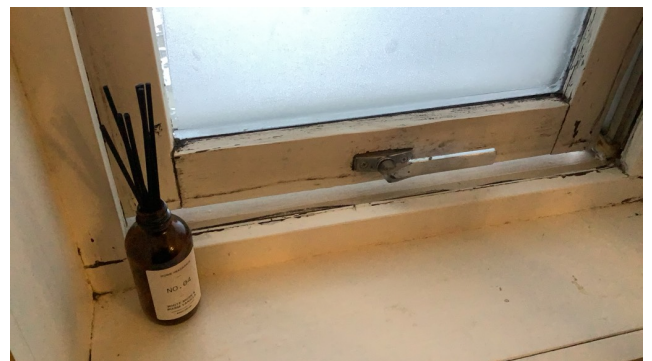
Fuktskader på vindu i bad.
