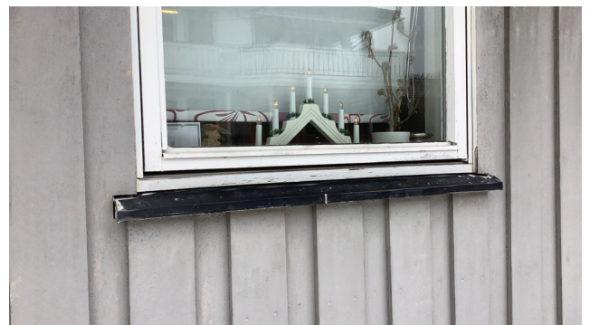
Fuktskader på vindu i bad.
