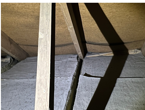
Isolasjonen ligger tett mot undertaket ved raftet
