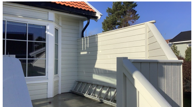
Det er ikke montert rekkverk.
