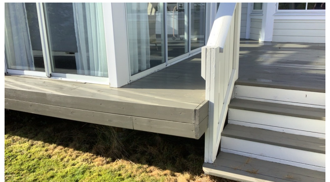
Det er ikke montert rekkverk.
