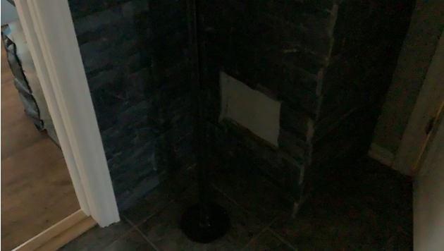
Sotluke i hall med fliser på gulvet.
