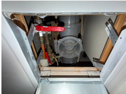
Inspeksjonslukke for stoppekran og stakepunkt
