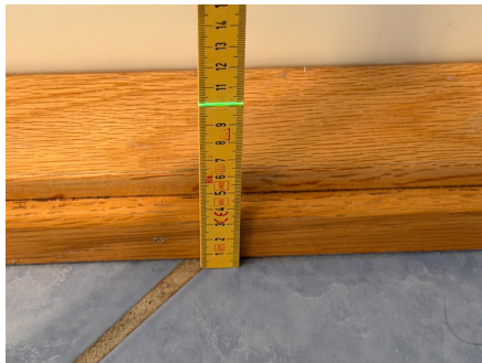
Fallforhold ca. 100 mm overkant gulv ved terskel
