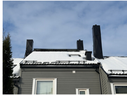
Taktekking er snødekt
