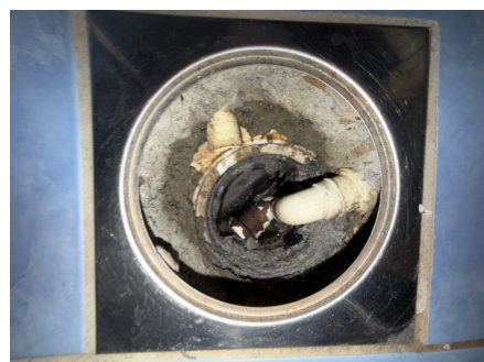
Plastsluk med klemring
