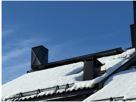
Taktekking er snødekt
