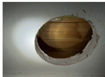
Hulltaking i tilstøtende gang
