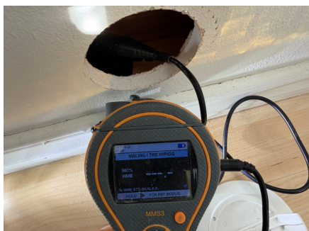
Hulltaking i tilstøtende gang
