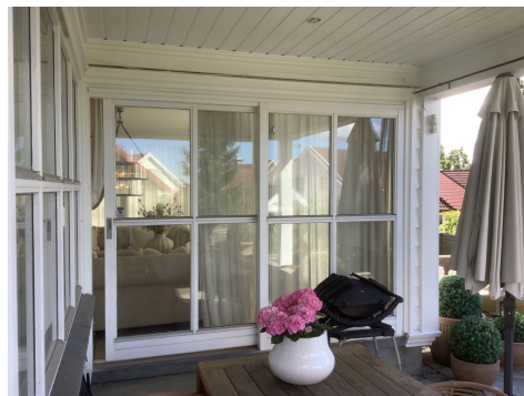
Heveskyvedør fra stue til terrasse.
