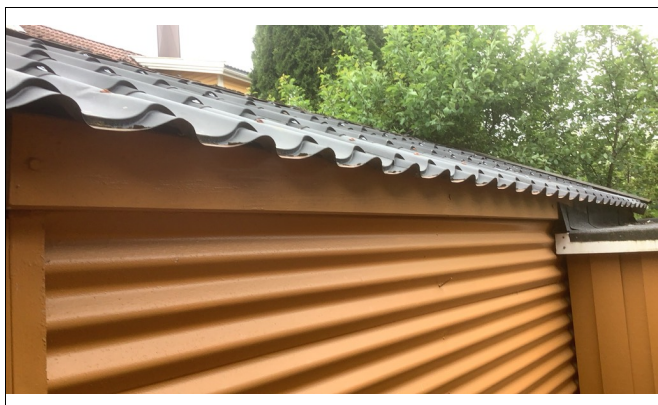
Vegg og tak på carport og bod.
