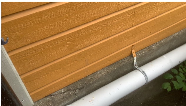
Kledningen ligger tett mot mur.
