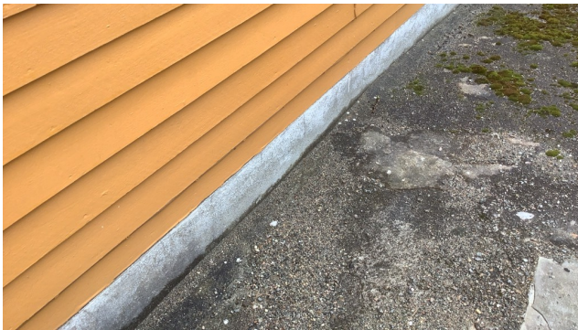
Kledningen ligger tett mot mur.
