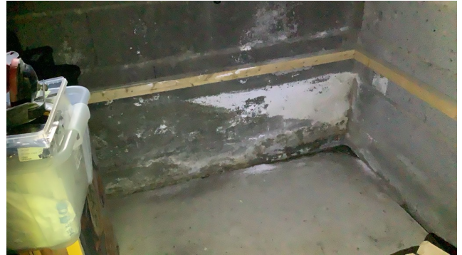
Fuktmerker på lecavegg i kjeller.
