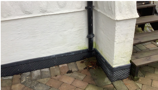
Nedløp før til rør i bakken, men ukjent hvor disse er tilkoblet.
