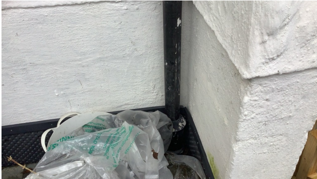
Nedløp før til rør i bakken, men ukjent hvor disse er tilkoblet.
