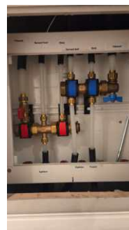
Vannfordelingsskap sokkeletasje
