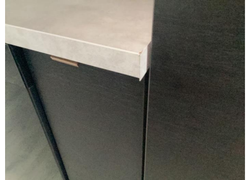
Lite skade på kant.
