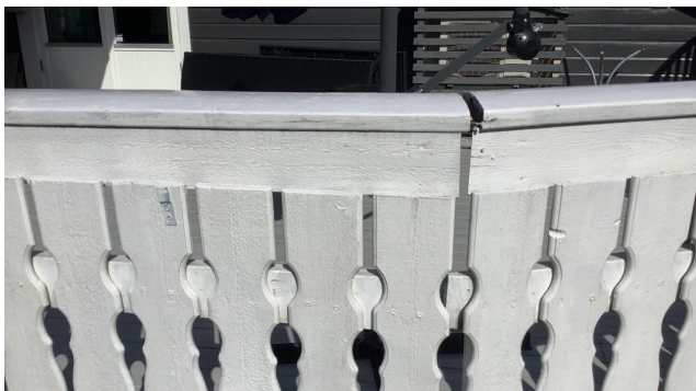
Løst rekkverk.
