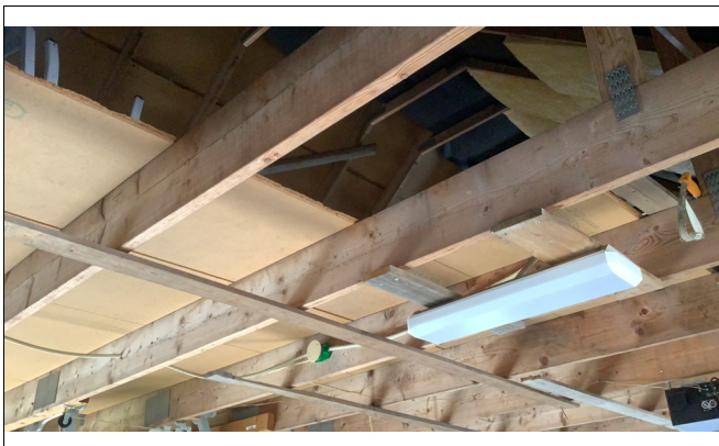
Loft i garasjen.
