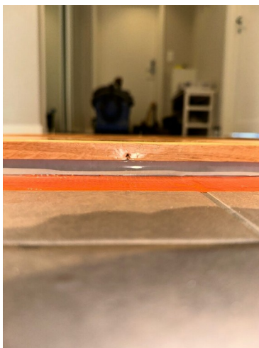
Foto 4. Terskelpartiet i snitt. Eikelist øverst, forsegling i overgangen mot membranoppkant, membranbånd synlig under.
