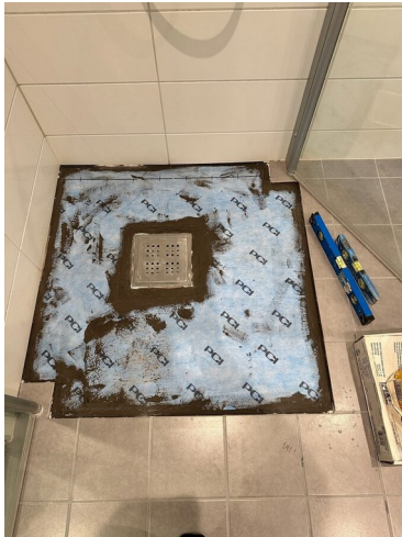
Foto 6. Under arbeid. PCI membranduk limt ned med 2-komponent membran over hele den avdekkede flaten, ført inn mot og rundt sluket.
