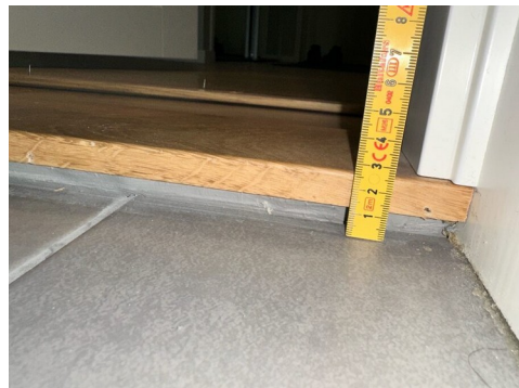
Foto 7. Måling ved dørterskel.
