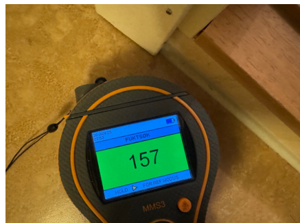
Fuktsøk ved terskel/dør
