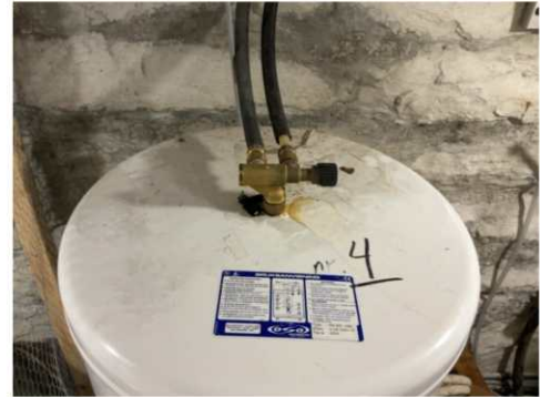
Noe rust vann ved kobling v
