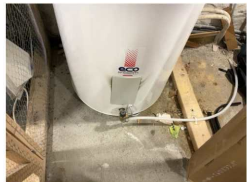
Noe rust vann ved kobling v
