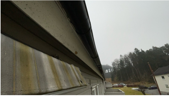
Deformasjon på takrenne
