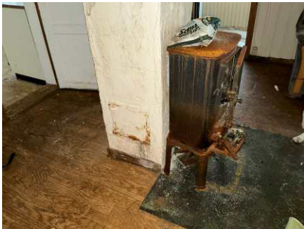
Sprekker og skader i pipe registreres.
