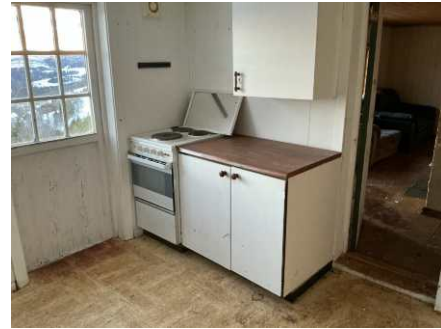
Kjøkkeninnredning etablert på vegg mot stue. Det er manglende forsert avtrekk over stekesone. Det er dog etablert elektrisk vifte på vegg.
