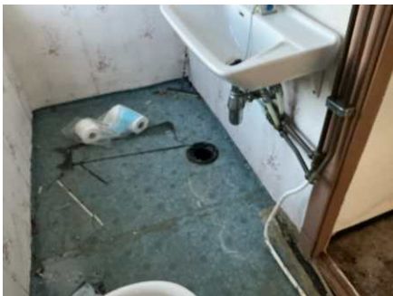
Vannledninger på bad.
