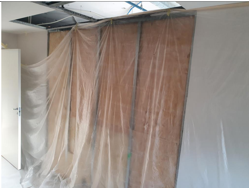
Soverom, vegg har blitt åpnet ifbm inspeksjon.
