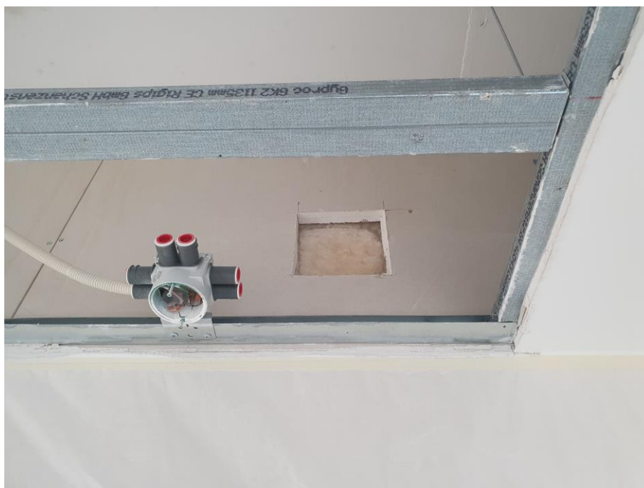
Over himling. Ingen tegn på fukt/skjolder.
