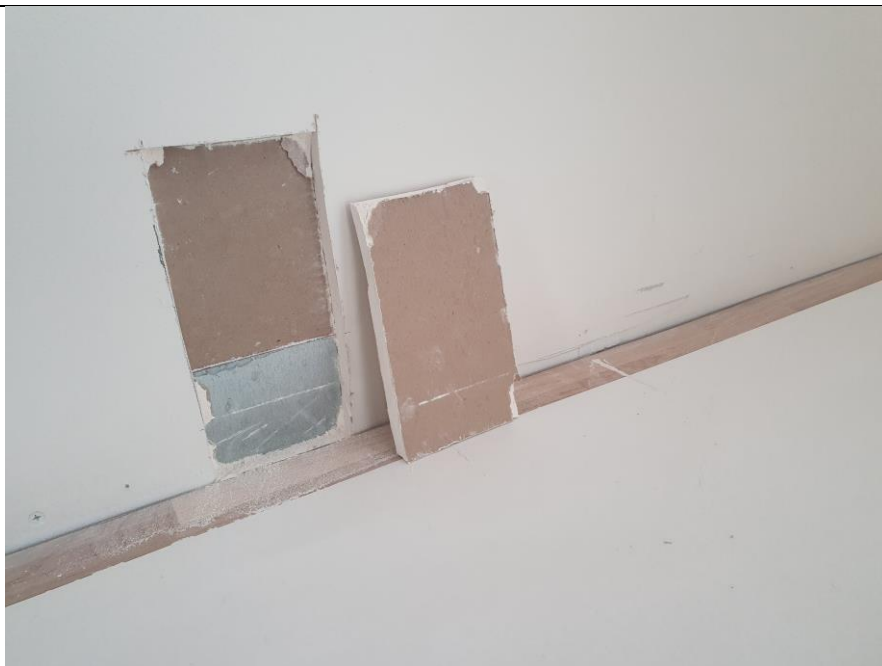
Vegg stue mot nabo. Ingen tegn på muggvekst/skjolder etc.
