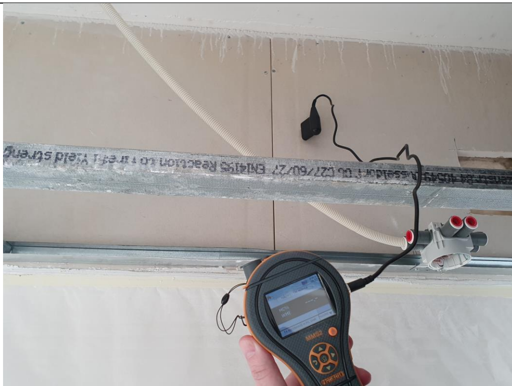
Ingen utslag på fukt ved bruk av pigger.
