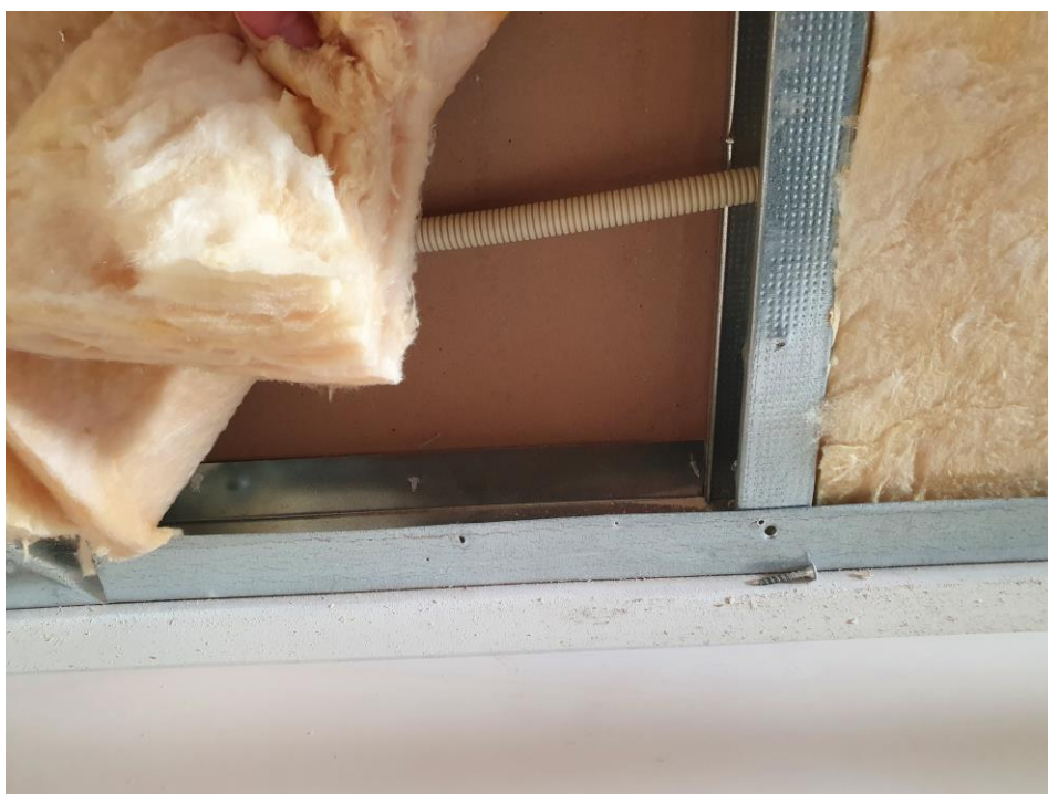
Gipsvegg mellom stue og soverom er uten tegn på fukt/skjolder.
