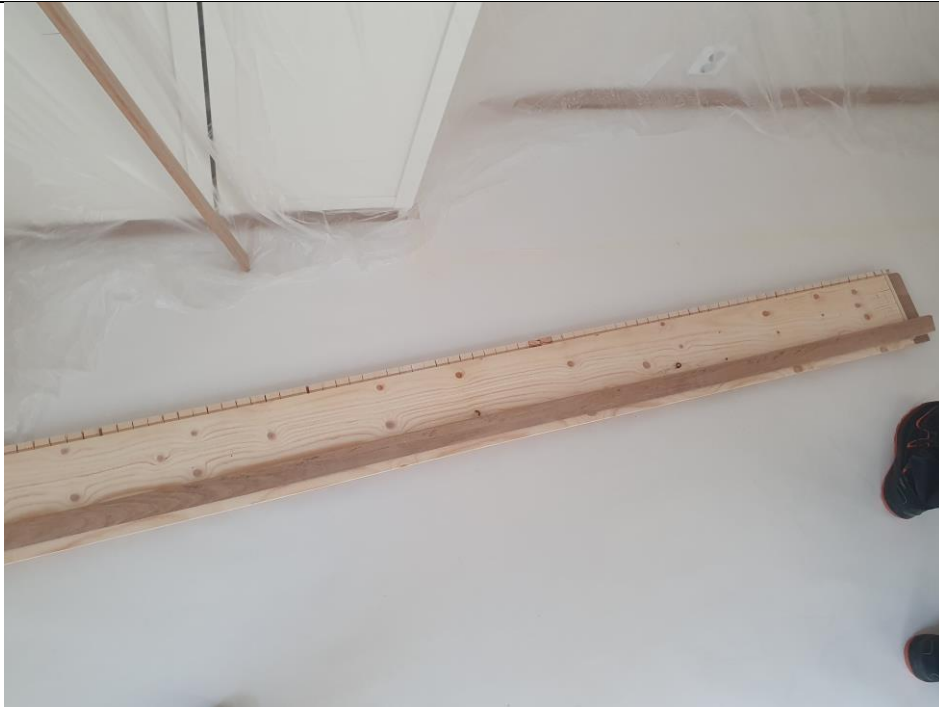
Parkettgulv og gulvlist soverom mot stue. Ingen tegn på skjolder/fukt.
