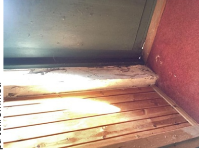
Avskallinger i muren ved ytterdøren i kjeller.
