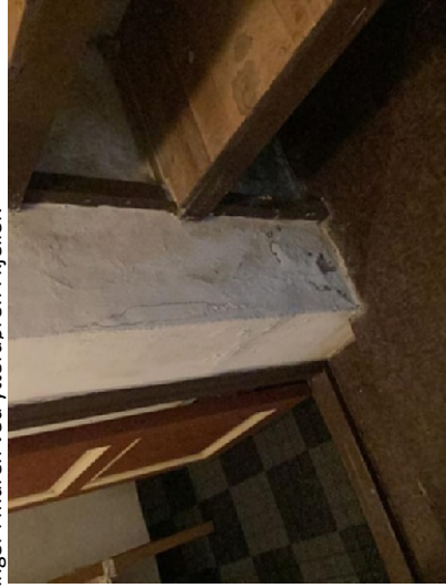
Avskallinger i muren ved ytterdøren i kjeller.
