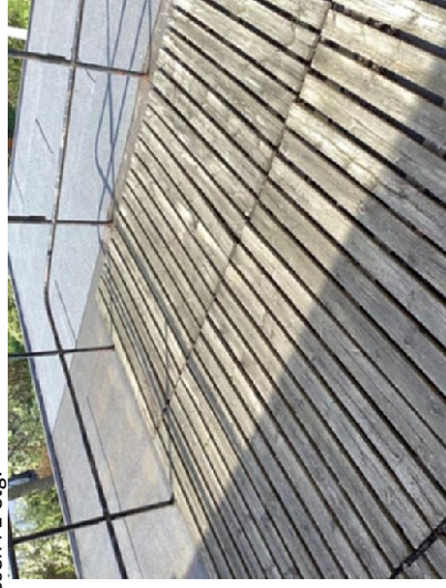
Takterrasse med terrasselemmer og smijernsrekkverk.
