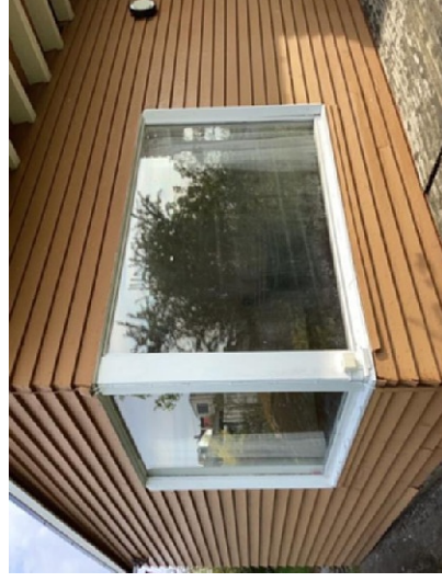
Punkterte vinduer i stuen.
