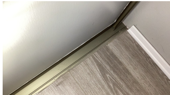
Laminatgulv på soverom lagt inn mot skyvedører
