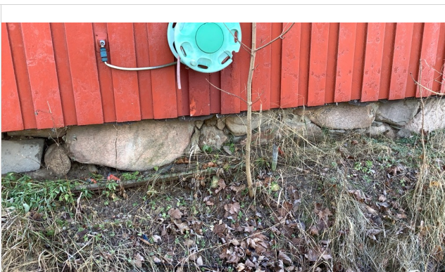
Mur i Granitt.
