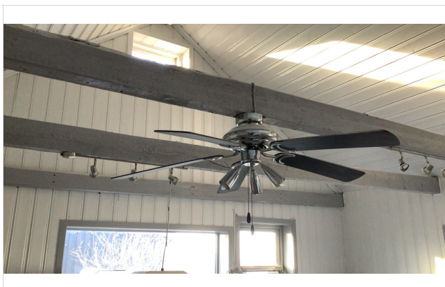
Skråhimling i stuen.
