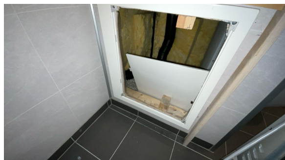
Inspeksjonsluke bak innebygd toalettsisterne.
