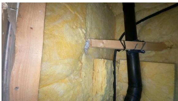
Ingen synlig diffusjonssperre (plast) i nisje bak innkasset toalett i andre etasje.
