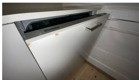
Front på oppvaskmaskin har fukt/svelleskader.
