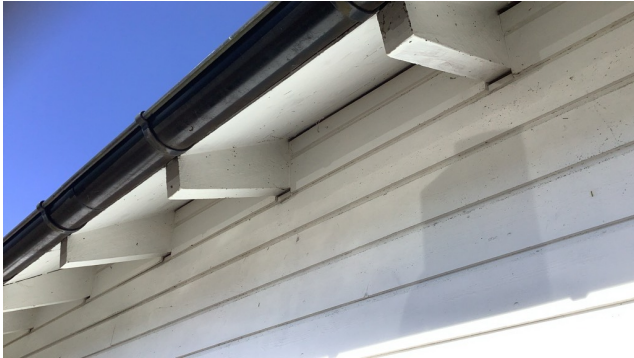
Liten luftespate i gesims
