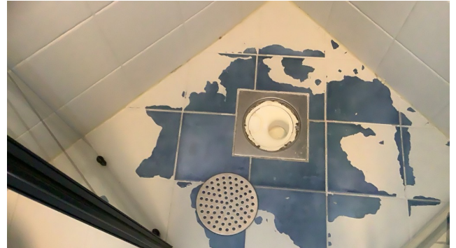
Malingen flasser på gulvflisene i dusjnisen.
