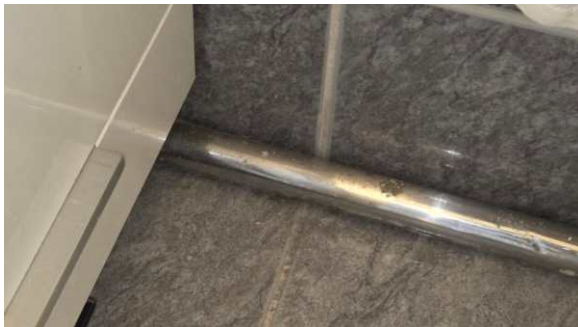
Avløpsrør fra dusjkabinettet til sluk
