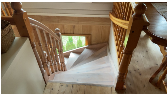
Det mangler håndløper i deler av trapp.
