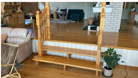
Det mangler håndløper i deler av trapp.
