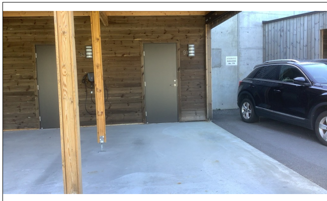
Carport med bod i enden.
