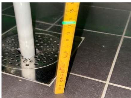
Fallforhold ca. 135 mm overkant gulv ved slukrist
