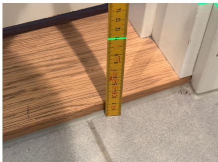
Fallforhold ca. 110 mm overkant gulv ved terskel
