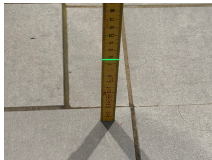
Fallforhold ca. 115 mm overkant gulv ved dusjsone
