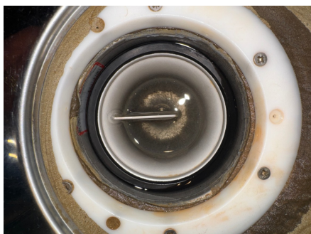
Stålsluk med klemring og synlig membran/mansjett
