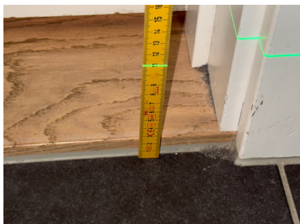
Fallforhold ca. 110 mm overkant gulv ved terskel
