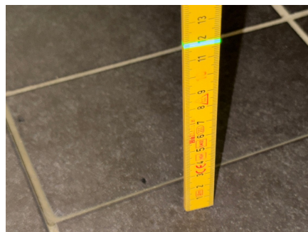
Fallforhold ca. 118 mm overkant gulv ved dusjsone
