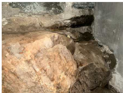
Synlig berg i kjeller, hvor det er vann som trenger inn under mur langs berg/fjell.
