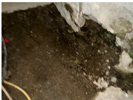
Fukt i kjeller påvist. Det er stedvis manglende betong mot grunn
