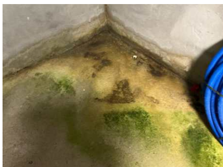
Fukt i kjeller påvist. Det er stedvis manglende betong mot grunn
