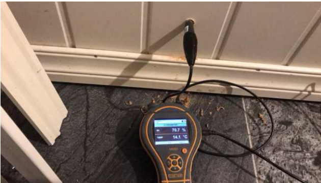
Bilde viser måling av luftfuktighet (RF)
