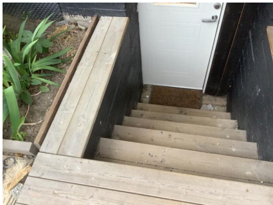
Trappen har ikke rekkverk.
