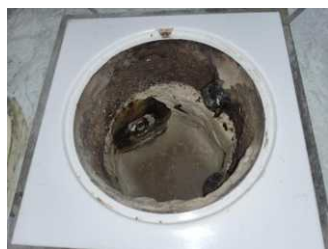
Tettesjiktets tilslutning til sluk - Sluk bad
