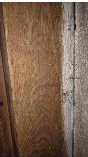
Flyvehull fra stripet borebille i takbjelke
