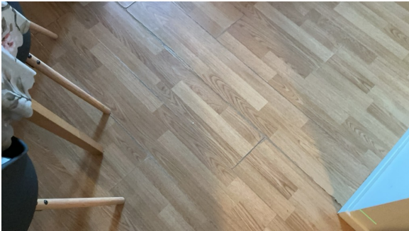
markant skade på laminatgulv
