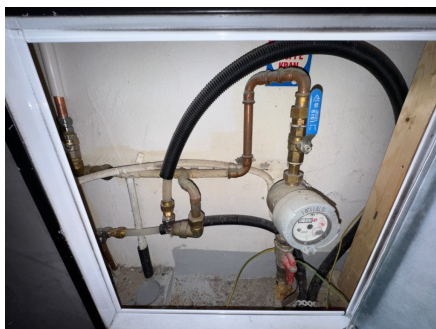
Inspeksjonsluke med stoppekran
