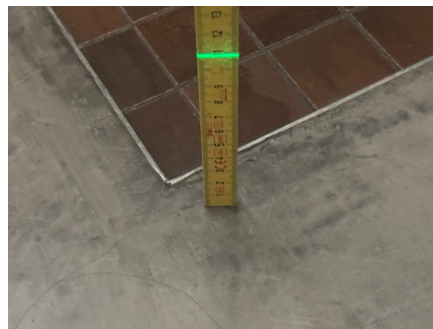
Fallforhold ca. 109 mm overkant gulv ved dusjsone
