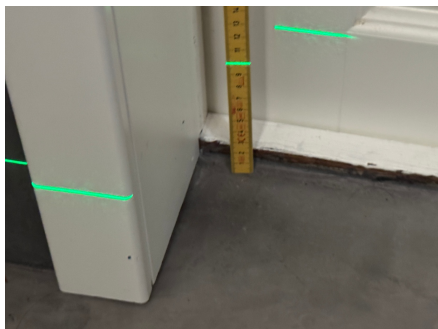
Fallforhold ca. 99 mm overkant gulv ved terskel
