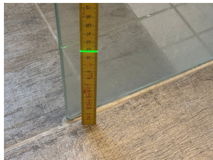
Fallforhold ca. 119 mm overkant gulv ved dusjsone
