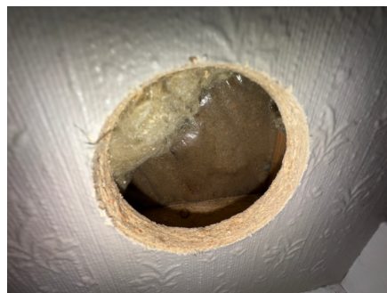
Hulltaking - utført i 2024
