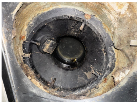
Plastsluk med stakemutter fra byggeår
