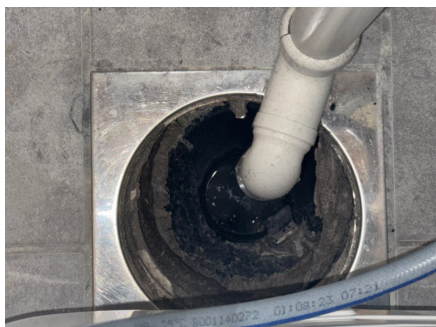
Plastsluk med stakemutter fra byggeår
