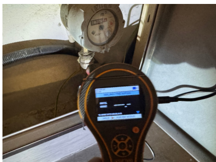
nspeksjonsluke i nedkant vegg under servantinnredning
