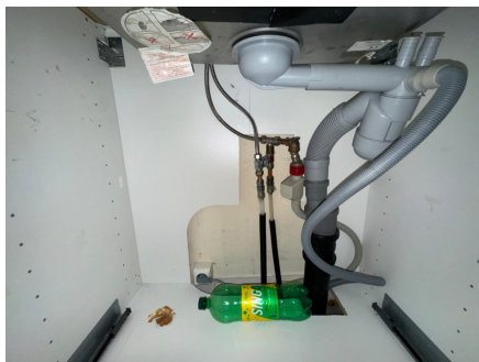
Det mangler tettemuffer i enden av varerør på rør-i-rør-system
