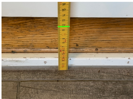
Fallforhold ca. 117 mm overkant gulv ved terskel
