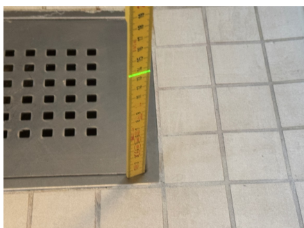
Fallforhold ca. 135 mm topp slukrist i dusjsone
