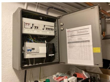
Sikringskap i kjeller med automatsikringer og jordfeilautomater.
