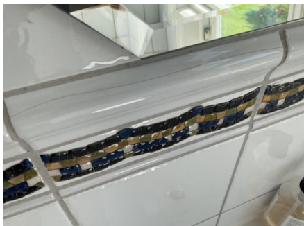
Det er sprekker i enkelte veggfliser.
