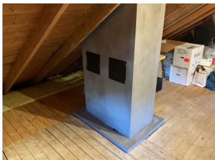
Røykerør fra grue i kjeller er tettet med tøystoff.
