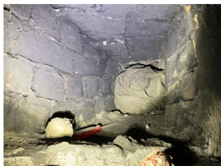
Røykerør fra grue i kjeller er tettet med tøystoff.
