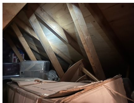
Del av takkonstruksjon og loft over tilbygg i stua.
