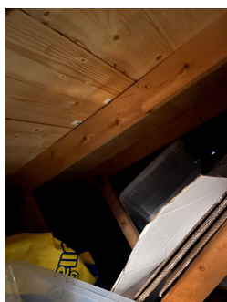
Del av takkonstruksjon og loft over tilbygg i stua.
